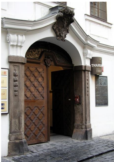
Obr. 01 Portál budovy politechniky
